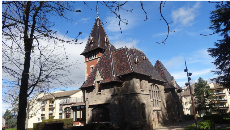
Vue arrière de la maison
